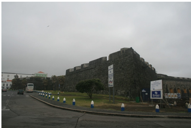
Forte de São Brás em Ponta Delgada, ilha de São Miguel
