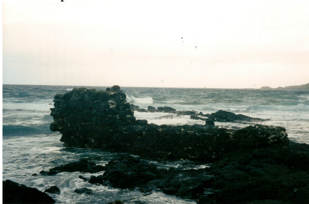
Forte de São Fernando, Praia da Vitória, ilha Terceira.
