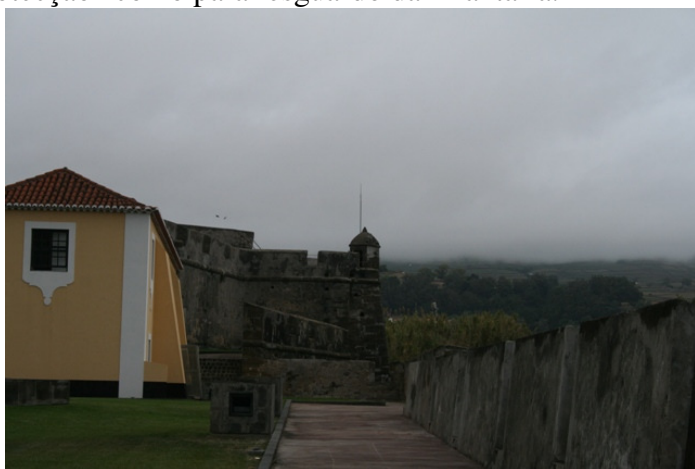
Forte de São Sebastião, Angra do Heroísmo, ilha Terceira
