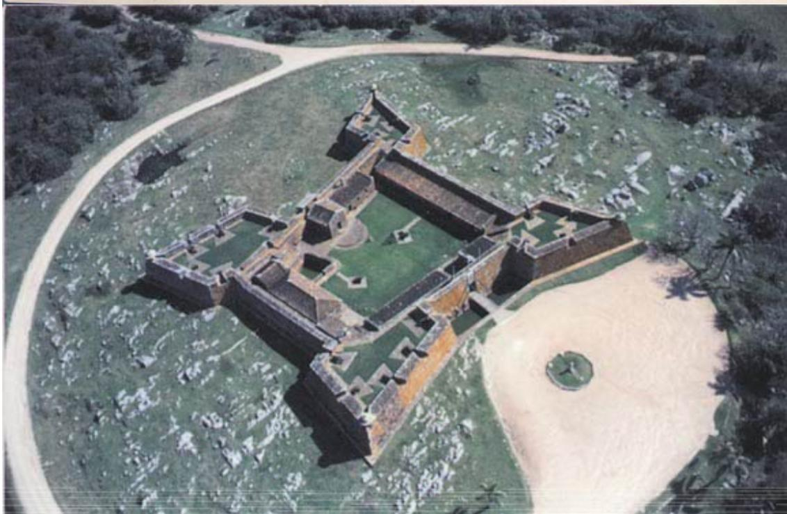
**Estructura:** fuerte de base romboidal, que comúnmente se refiere como de sistema Vauban en realidad abaluartado, con cuatro baluartes salientes que llevan el nombre de los puntos cardinales a los cuales están orientados, 18 troneras, construcciones exteriores e interiores en piedra acuñada del lugar, sin revestimiento, techos de tejas musleras, foso en
