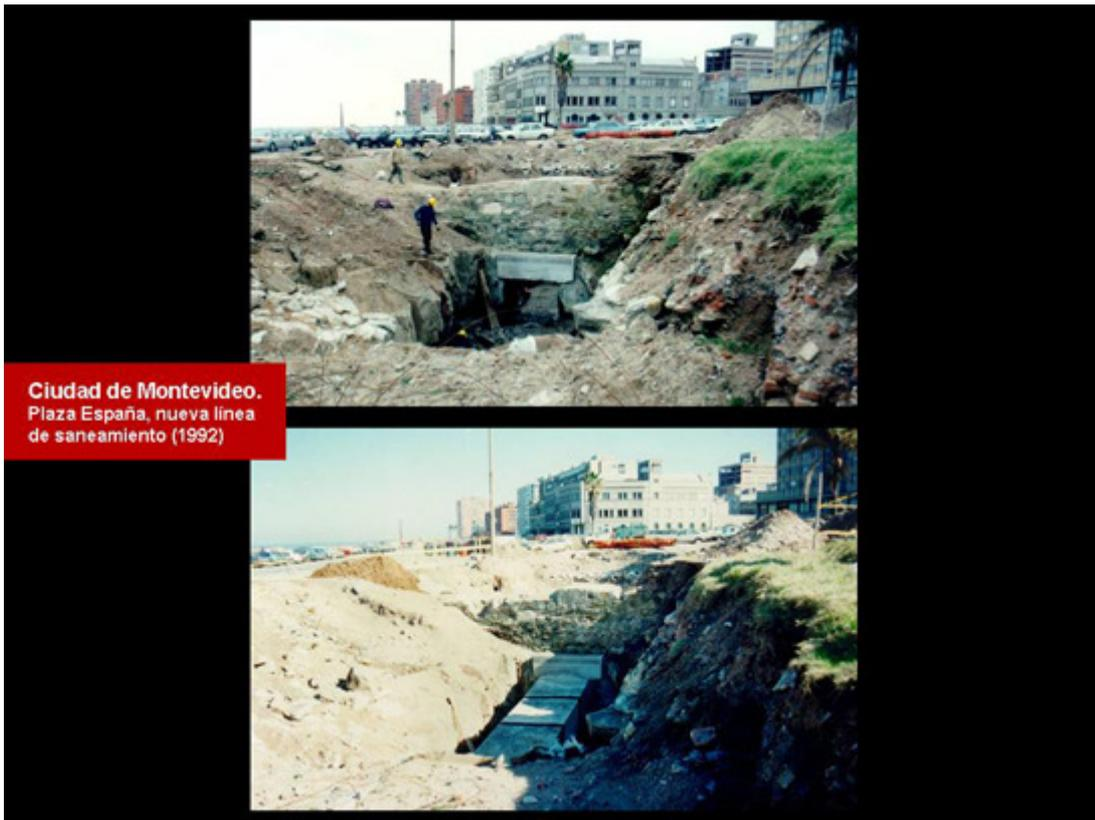
Foto superior: Obra de ingeniería, perforación de la roca del sustrato y viga de hormigón sujetando el muro interno de ese sector de la fortificación.
